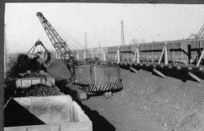
Széncsuszda és felrakás V.tip. kotrógéppel.
