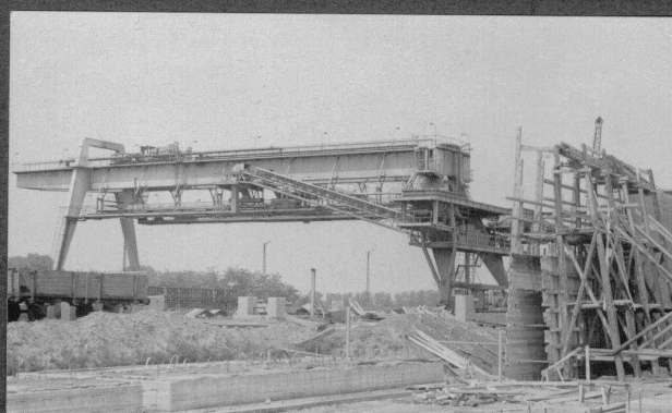
Nyitott ömlesztettáru átrakó építése Eperjeske átrakó pu.-on.
