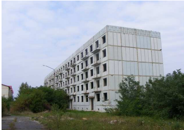
5. sz. kép A szolnoki „kijevi” típusú lakóház
