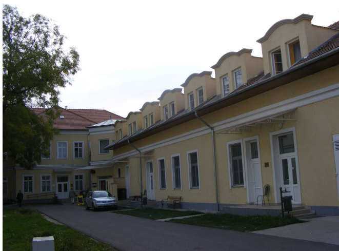
7. sz. kép A volt Honvéd laktanya épületei (MVA)
