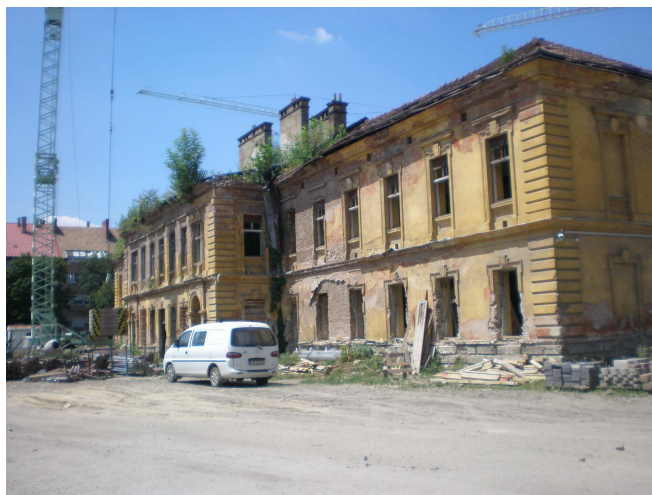
14. sz. kép Felújítás alatt a Frigyes laktanya egyik épülete
